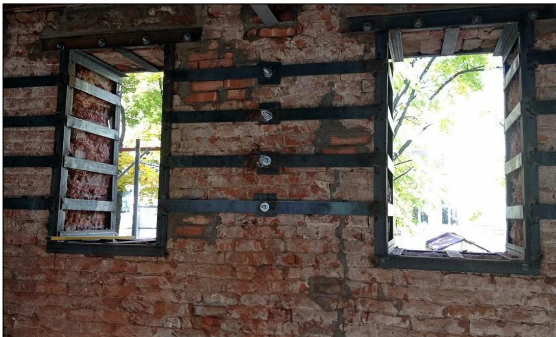
Рис. 1. Пример укрепления вертикальных несущих конструкций (кирпичная кладка)
